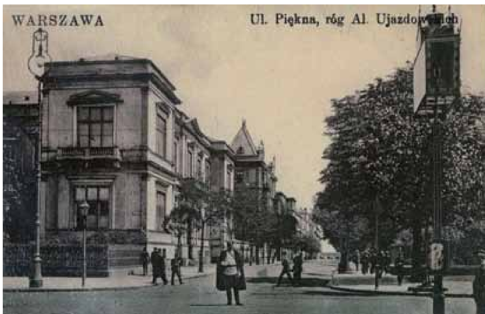
Widok narożnika ul. Pięknej i Al. Ujazdowskich. Fot. 1905-1914. Archiwum Muzeum Historycznego m.st. Warszawy /Arch.Ik.2367/ The view of the Piękna and Ujazdowskie Avenue street corner. Photo from ca 1905-1914. Source: Warsaw's City Historic Museum archives, cat. nr 2367
